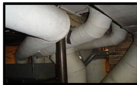
Pemanfaatan bahan asbes sebagai insulasi panas dalam bidang keteknikan (sumber: asbestoslabs.com.au , diunduh: 06 April 2015)
