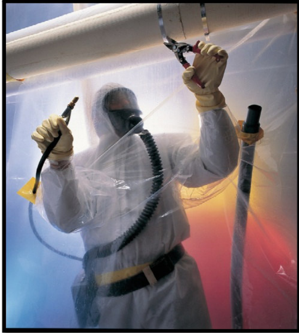
Alat pelindung diri bagi pekerja yang menangani bahan mengandung asbestos (Sumber: ct.gov, diunduh: 09 April 2015)
