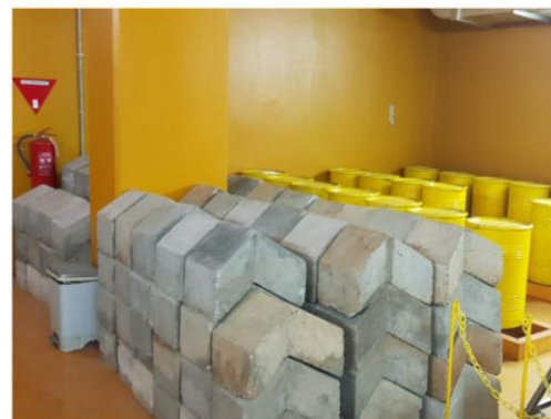
Gambar 2. Paving block pembatas ruang limbah
