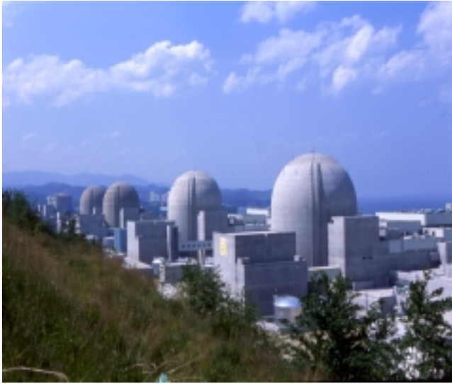
Gambar 39. Sederet PLTN di Ulchin, Korea Selatan, dengan kubah pengungkung yang dapat menahan zat radioaktif.
