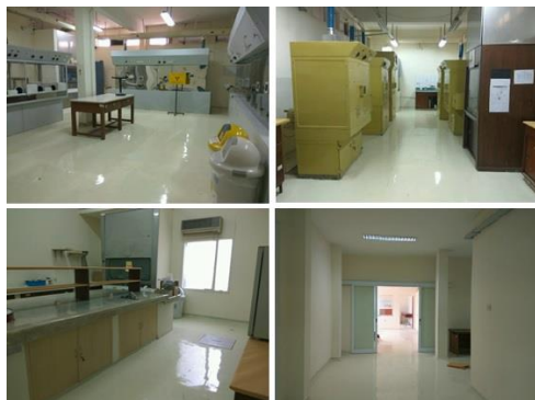
Pemasangan epoxy lantai dalam rangka Revitalisasi Lab Radioisotop dan Senyawa Bertanda
