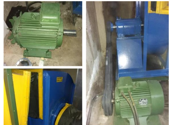
Perbaikan Sistem Blower untuk Persyaratan dan Keselamatan Kerja dengan Zat Radioaktif
