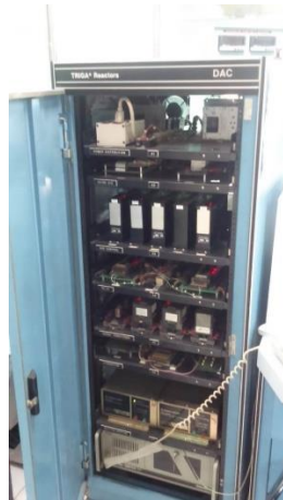
Penggantian unit motor controller batang kendali (VEXTA)
