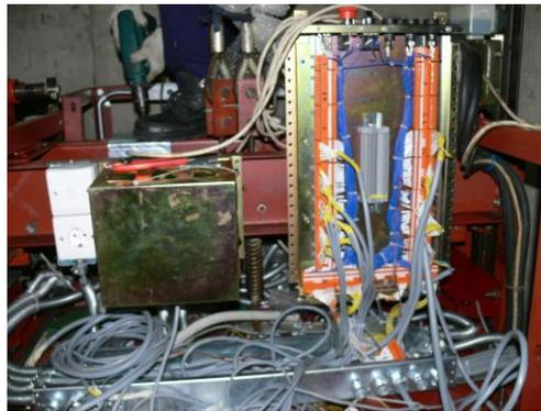
Gambar 8. Pemasangan *Inspection box* baru
