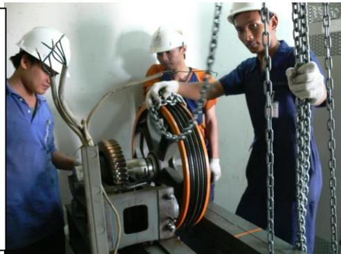
Gambar 3. Pembongkaran mesin lift
