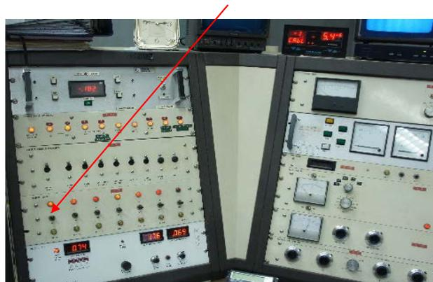
Gambar 4. Sistem Kontrol air pendingin pada siklotron CS-30 BATAN mode operasi.
