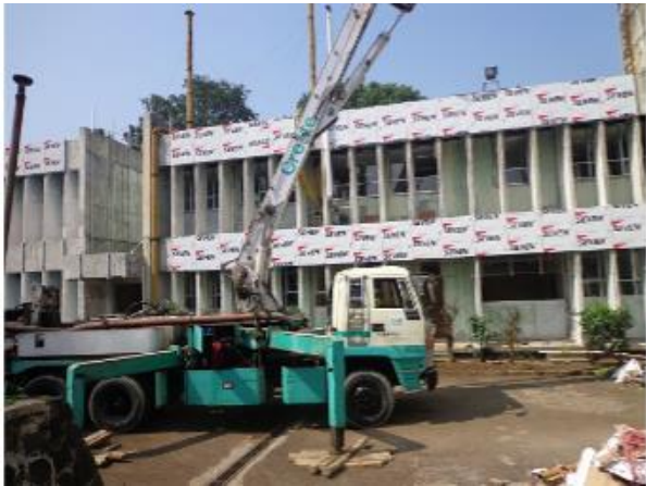
Gambar 21. Pengerjaan screeding atap Gedung F
