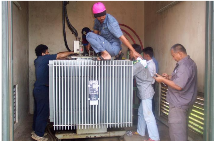
Gambar 2. Pelepasan Kabel Trafo BHT03 [3]
