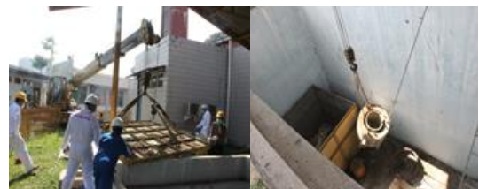
Gambar 3. Pengangkatan penutup boks wadah limbah reflektor dan reflektor dengan crane .
