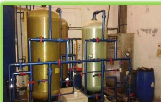
Gambar 6 Hasil Pengembangan Sistem Kolom Anion dan Kation
