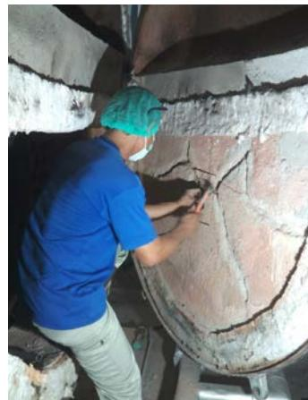
Gambar 3. Perbaikan penambalan retakan semen isolator pintu *back hood*
