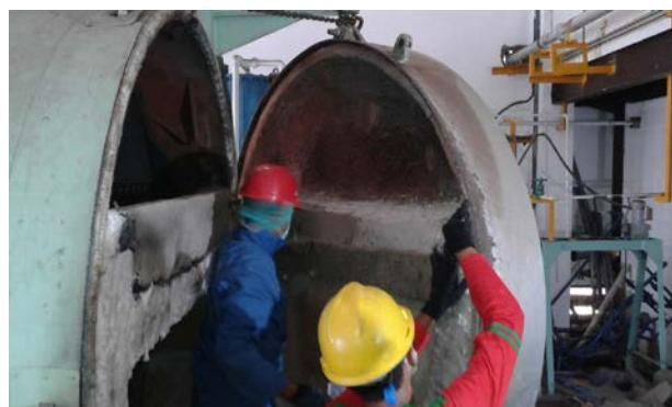
Gambar 4. Perbaikan asbestos isolator pintu *back hood*
