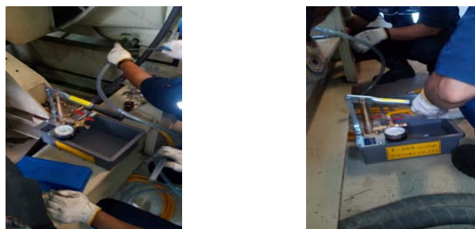
a). Pemasangan pressure test pump b). Pemberian tekanan oleh pressure test pump
