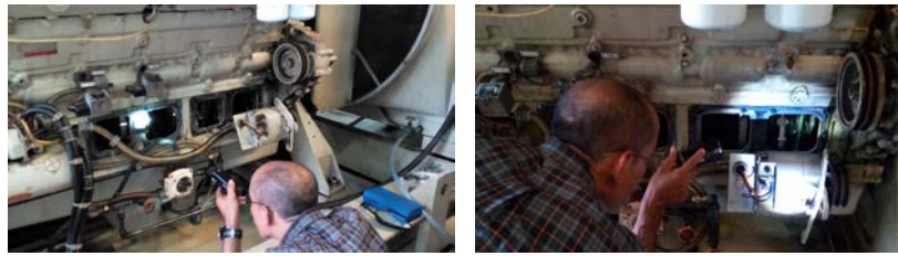
a). Pemeriksaan kebocoran pada cylinder head No. 3 Bagian Kiri
