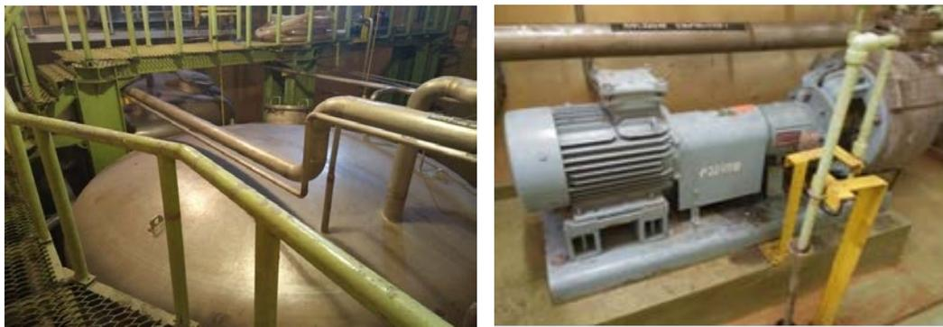
Gambar 2. Tangki Destilat dan Pompa Destilat P2209B
