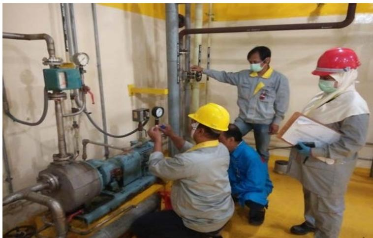
Gambar 4. Perbaikan pipa pendingin pompa P 22008
