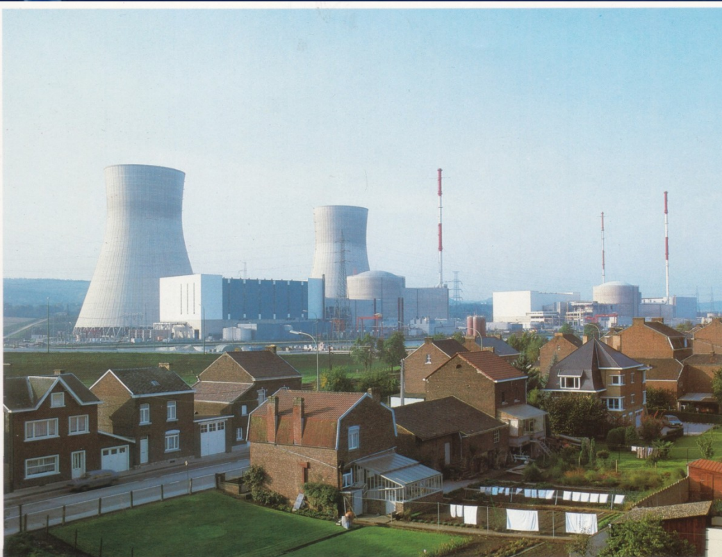
PLTN Tihange, 870 & 925 MW
