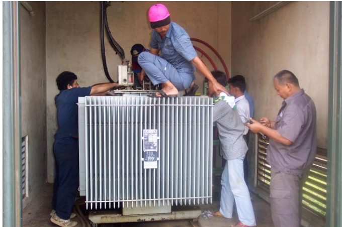
Gambar 2. Pelepasan Kabel Trafo BHT03 [3]
