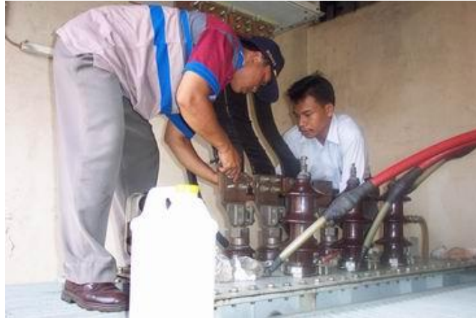
Gambar 5. Pemasangan kabel setelah dilakukan pengukuran [3]
