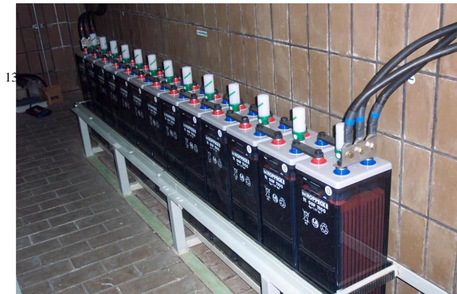
Gambar 5. Susunan Batere BTJ (+ 24 Volt)
