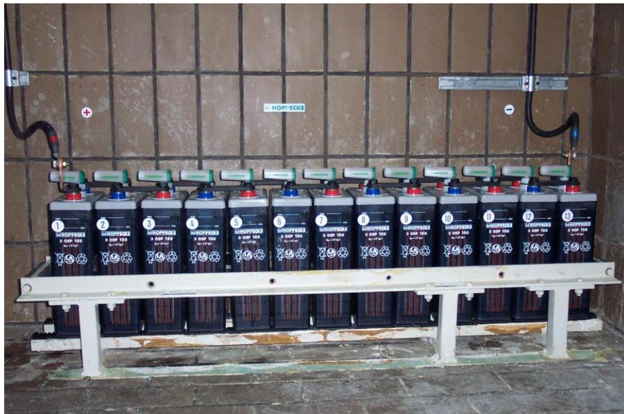
Gambar 6. Susunan Batere BTJ (- 24 Volt)
