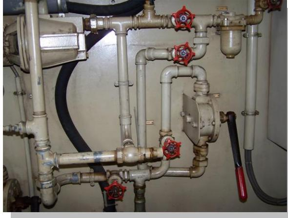
Gambar 2. Katup dan pompa bahan bakar diesel
