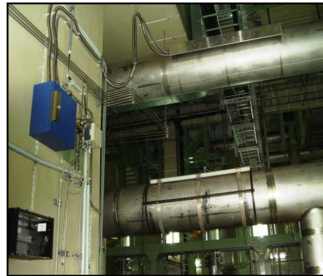
Gambar 7b. Komponen ATPM dipasang di bagian luar pendingin primer
