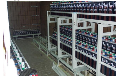
Gambar 5. Batere yang sudah terpasang di rak
