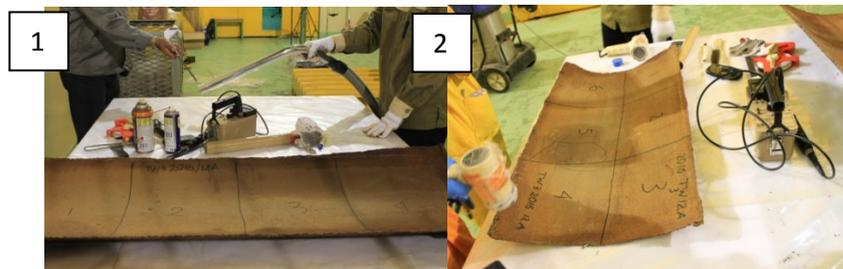
**Gambar 4.** Proses pembersihan kotoran dan *mapping grid* lembaran pelat<sup>1)</sup>, dan pengukuran tingkat kontaminasi permukaan dan paparan radiasi<sup>2)</sup>
