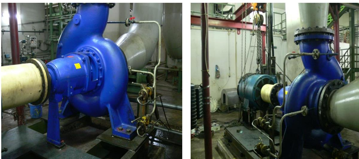
Gambar 10. Gambar pompa PA02-AP01 yang baru setelah terpasang
