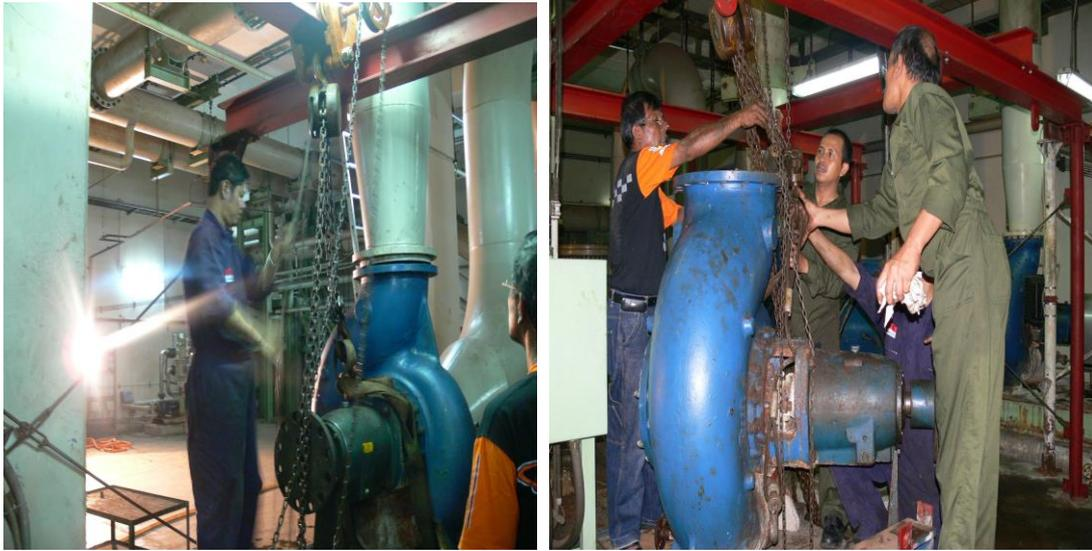
Gambar 7. Gambar kegiatan pembongkaran pompa
