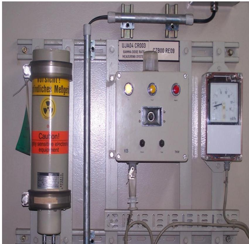
Gambar 2. Sistem Laju Dosis Gamma terpasang
