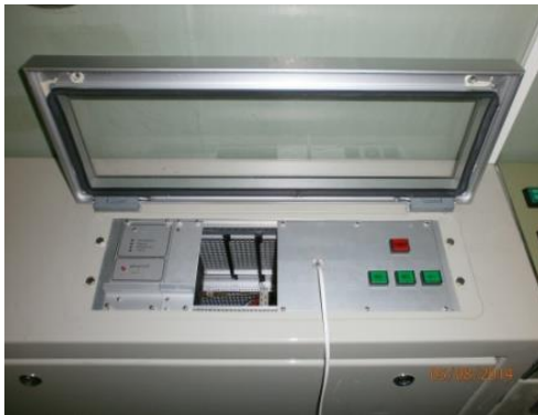
Gambar 8. Hasil instalasi akhir pembuatan perangkat keras Kendali Gamma Scanning
