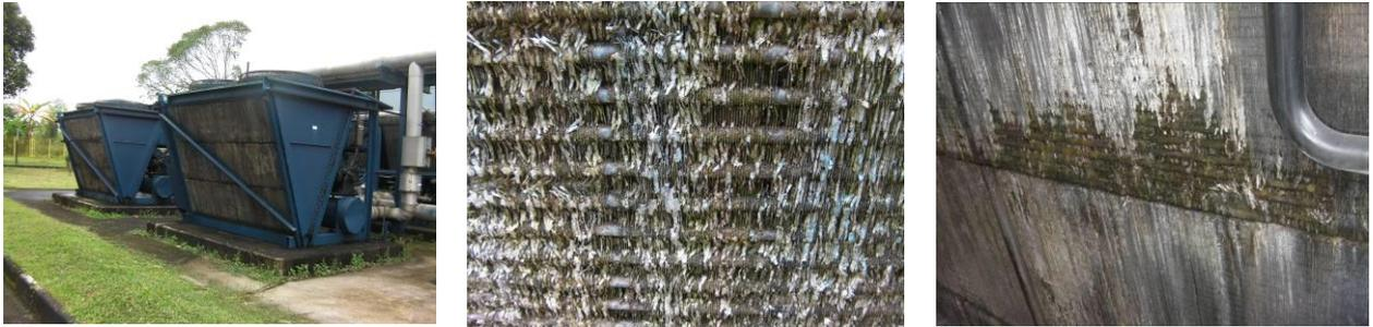
Gambar 10. Keadaan kondisi terkini unit *chiller* untuk proses air pendingin (*cooling water*) peralatan laboratorium Radiometalurgi dan MES
