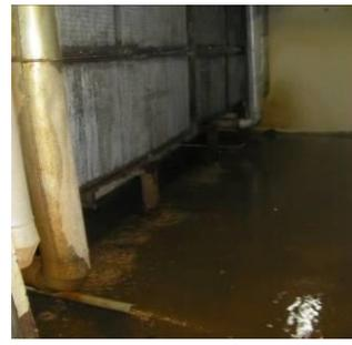
Gambar 9. Keadaan penukar panas *cooling coil* (CC 001) dan genangan air akibat kebocoran *header*
