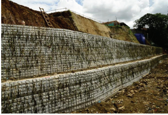
Gbr. 13. Konstruksi Geoframe Lereng Apartemen di Bogor, Jawa Barat.
