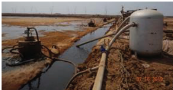
Gbr. 5. Perbaikan Tanah dengan Metode Vacuum Preloading .
