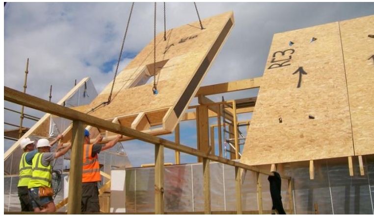
Gambar 4. Penggunaan I-Joist sebagai konstruksi panel lantai, panel dinding dan panel atap (Sumber : https://specificationproductupdate.com/2018/04/11/i-joists-versatile-answer-floors-walls-roofs/ )
