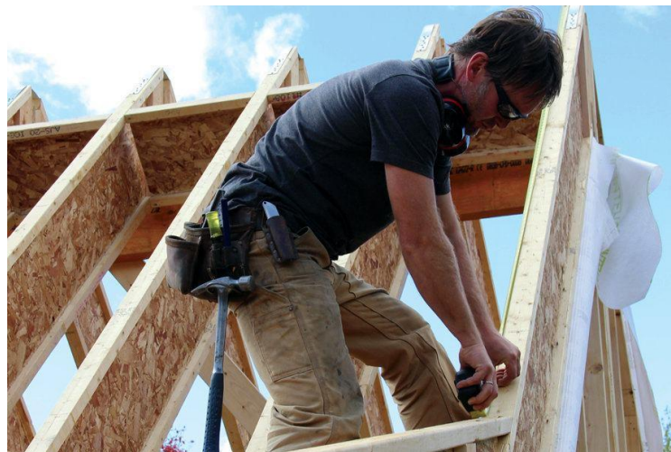
Gambar 3. Penggunaan I Joist sebagai elemen konstruksi rangka atap (Sumber : Jesper Kruse, 2014 https://www.jlconline.com/how-to/framing/framing-a-two-pitch-i-joist-roof_o )
