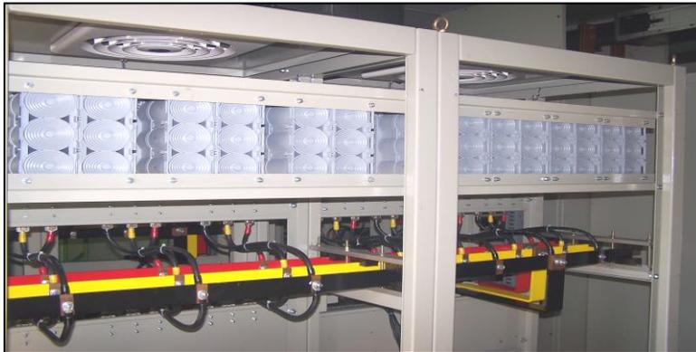
Gambar 9. Susunan kapasitor *bank* kapasitas 500 kVAr
