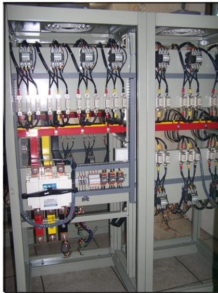
Gambar 10. Panel kapasitor *bank* kapasitas 500 kVAr
