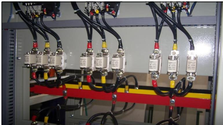
Gambar 10. Susunan *fuse* kapasitor *bank* kapasitas 500 kVAr
