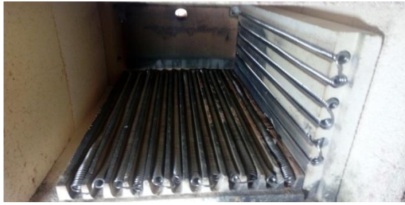
Gambar 13. Instalasi Heater Bagian Bawah dan Kanan
