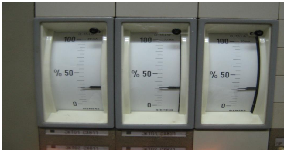
Gambar 6. Unjuk kerja Pengukur Aktivitas N-16 (JAC 01 CR 811/821/831)
