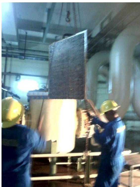
**Gambar 4:** Ram filter mekanik dikeluarkan dari tabung.
