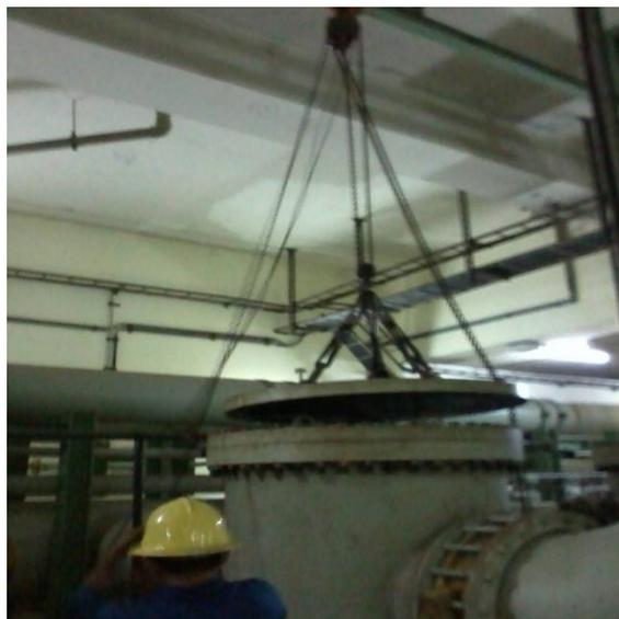
**Gambar 3:** Penutup tabung filter mekanik diangkat dan dipindahkan.
