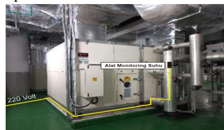
Gambar 6. Desain Pemasangan Alat Monitoring Suhu pada AHU
