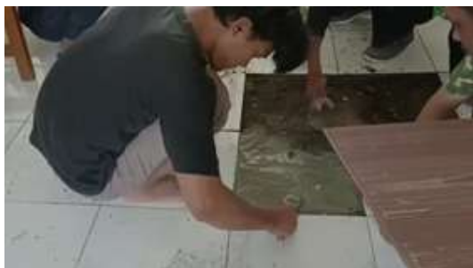
Gambar 11. Pekerjaan pemasangan keramik baru
