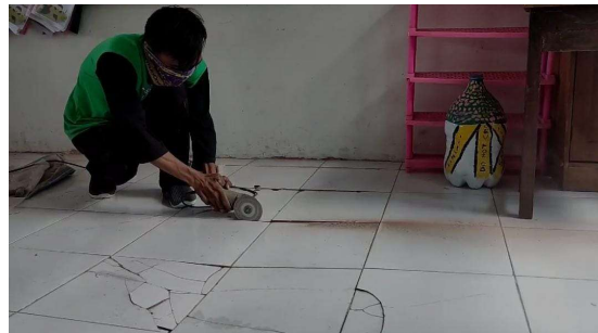
Gambar 10. Pekerjaan pembongkaran keramik lama
