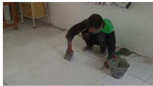
Gambar 11. Pekerjaan pemasangan nat keramik
