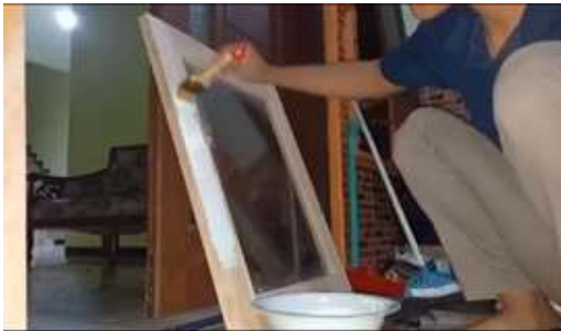
Gambar 12. Pekerjaan pengecatan jendela
