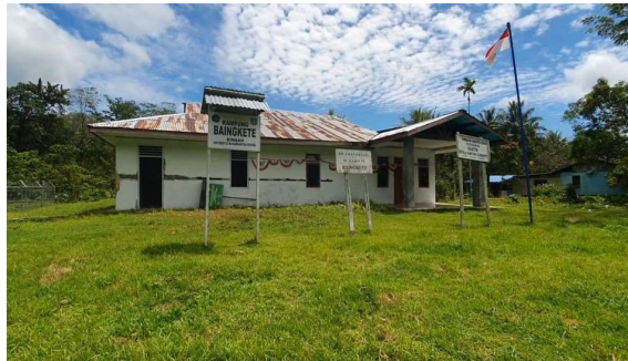
Gambar 1. Kondisi Kantor Kampung Baingkete, Distrik Mabon, Kabupaten Sorong
