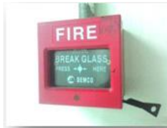
Gambar 3. Pengujian break glass dengan kunci kontak
