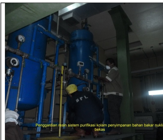
Gambar 5. Penggantian resin sistem purifikasi
