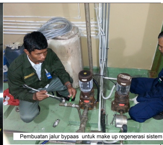
Gambar 6. Pembuatan jalur by pass sistem demin
