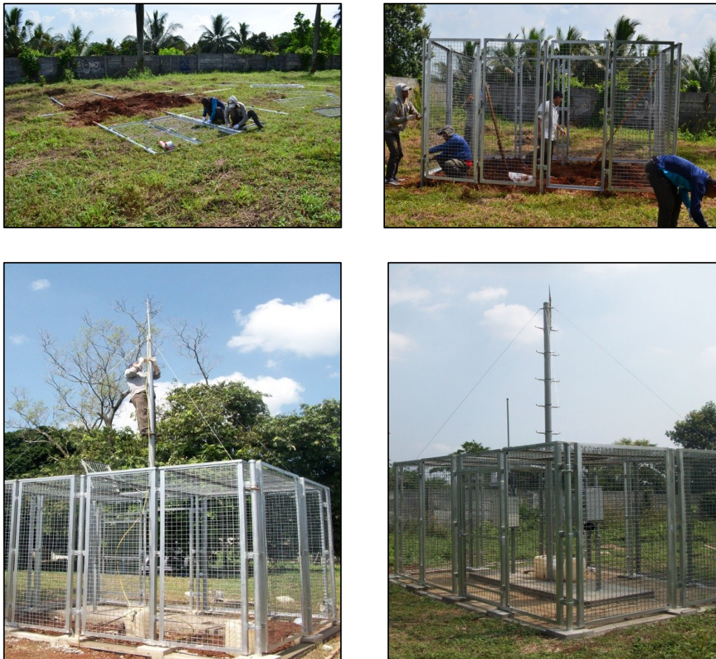
Gambar 2. Proses instalasi alat pemantau radiasi udara ambien stasiun LIPI
