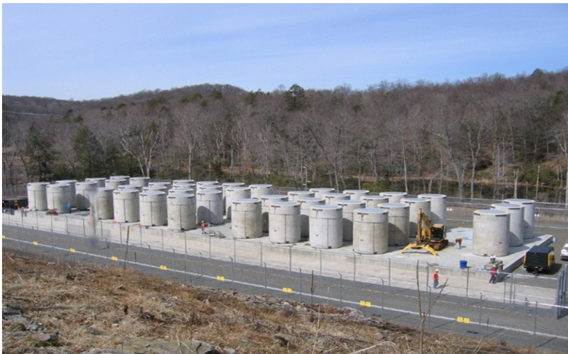
Gambar 4. Tempat Penyimpanan BBNB dari PLTN Sistem Dry Cask Storage
