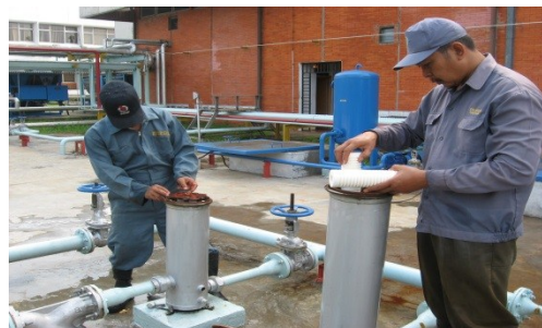
Gambar 8. Pemasangan Cartridge baru
