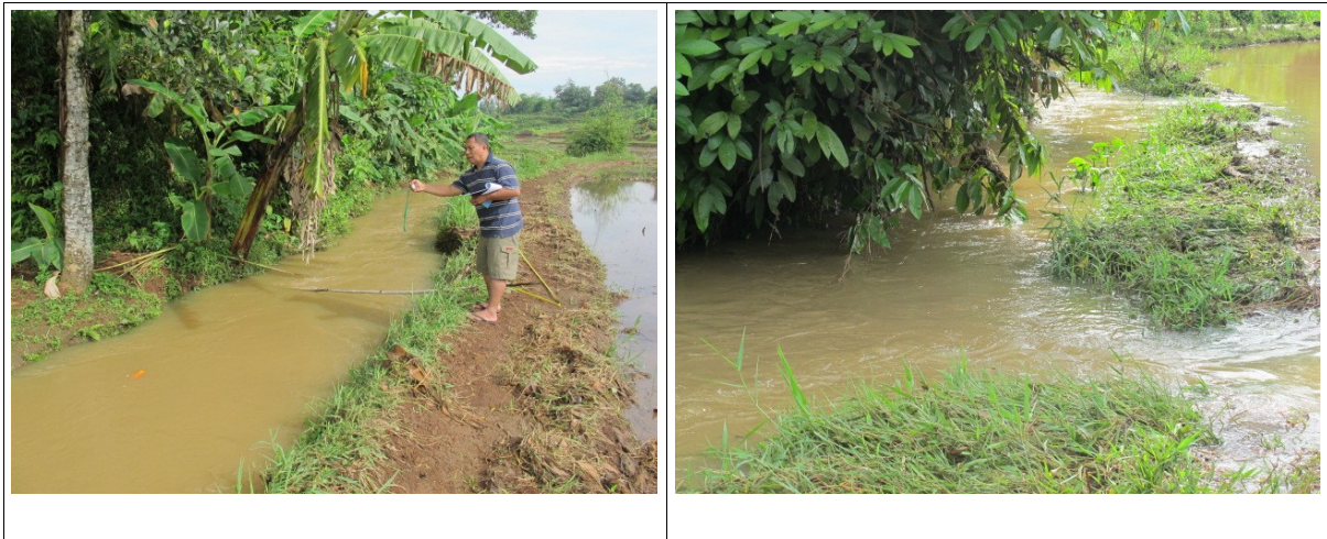
Gambar 2. Menunjukkan sungai Cisalak dalam keadaan banjir sehingga melimpah ke persawahan di sekitarnya.
