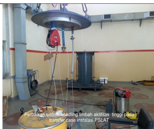
Gambar 4. Perbaikan sistem handling limbah aktivitas tinggi pada PSLAT
