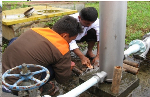
Gambar 6. Pembersihan Cartridge
