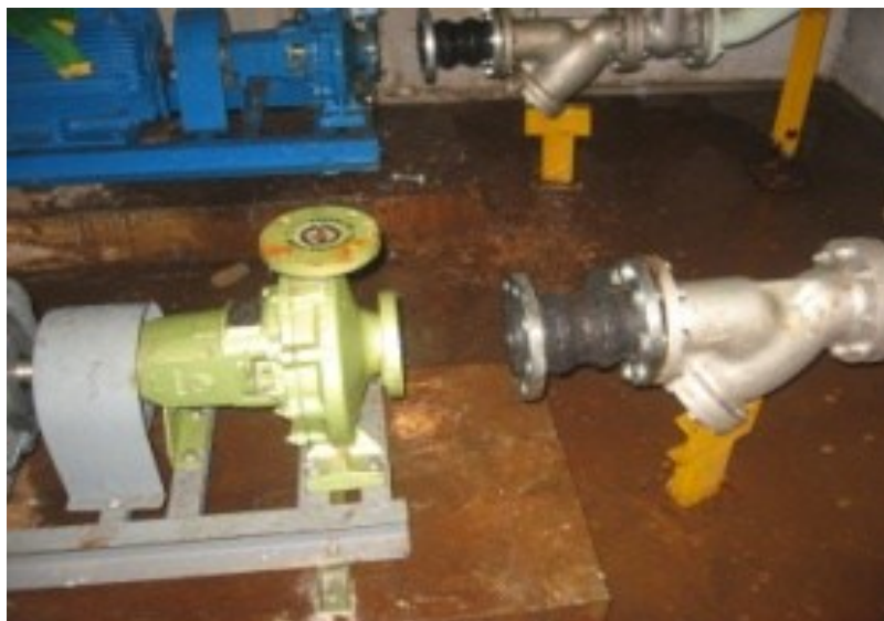
Gambar 3. Modifikasi flexible joint
