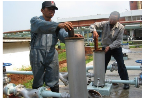
Gambar 4. Melepas Cartridge dari Casing
