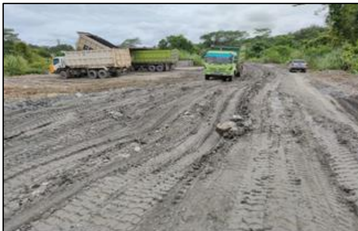
Gambar 3.2 Kondisi Jalan Bergelombang
