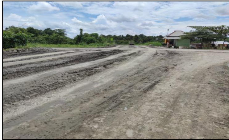
Gambar 3.3 Persimpangan Jalan Yang Tidak Terdapat Rambu Lalu Lintas Pada Jalan Hauling
