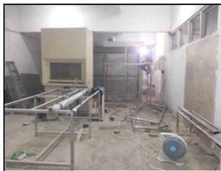
Gambar 9. Renovasi ruang Sol-Gel
