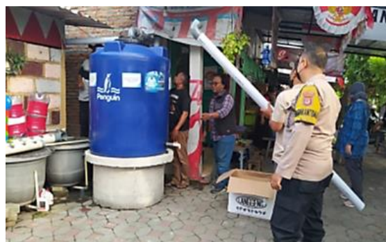
Gambar 8. Pemasangan alat dengan gotong royong
