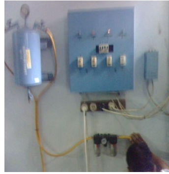
Gambar 11b. Instalasi untuk trap air
