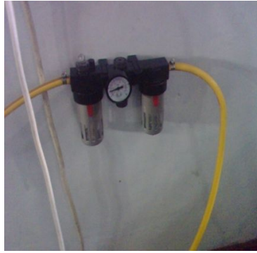
Gambar 11a. Trap air dipasang antara kompresor dan tangki
