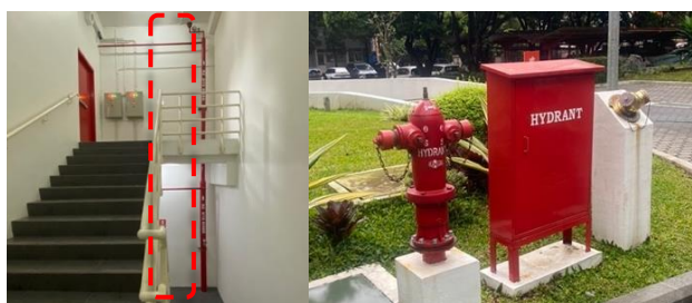
Gambar 4. Sistem pipa tegak dan sambungan pemadam kebakaran
