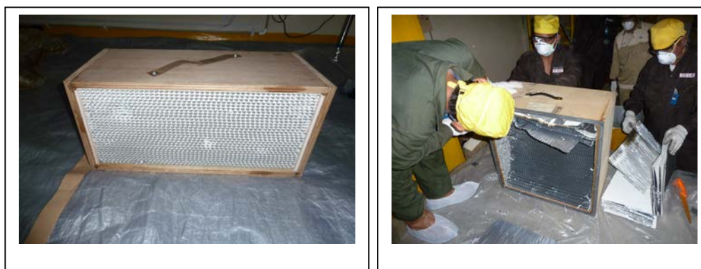
Gambar 1. Filter ukuran 60x60x30 cm dengan casing dari multiplek sedang dilakukan proses pelepasan Packing dalam kardus.
