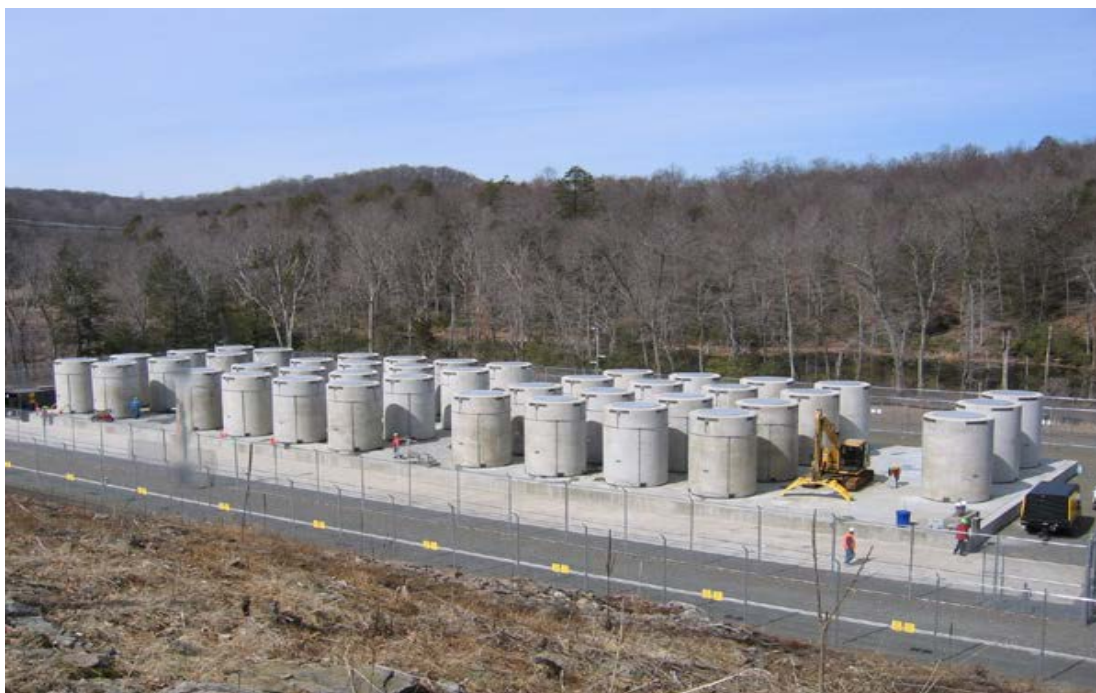
Gambar 4. Tempat Penyimpanan BBNB dari PLTN Sistem Dry Cask Storage [15]
