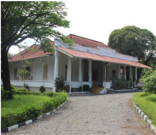
Gambar 3. Tampak muka rumah ADM Tersana Baru. (Sumber: Dokumen Balai Arkeologi Bandung, 2013)
