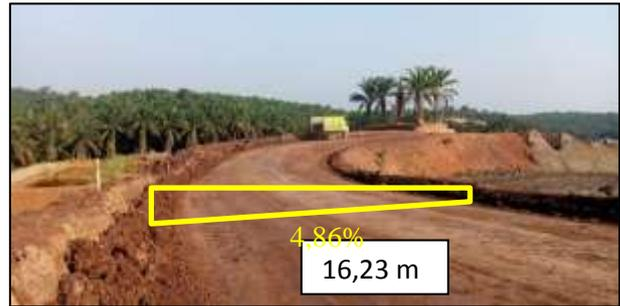
**Gambar 4.8** Superelevasi Aktual Jalan Angkut *Overburden*
