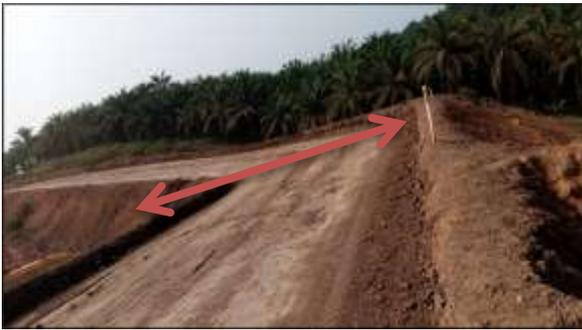
**Gambar 4.3** Lebar Jalan Angkut Tikungan pada Segmen E-F
