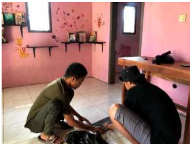
Gb. 2. Proses pemasangan rak untuk pojok baca
