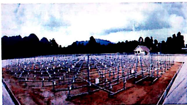
(a) Terletak pada Areal Antenna dengan diameter 110m, 560 batang Antenna
