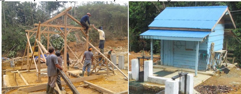
Gambar 11. Pembuatan rumah mikrohidro
