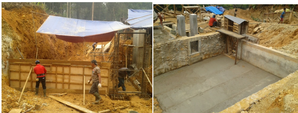
Gambar 10. Pembuatan bak penenang
