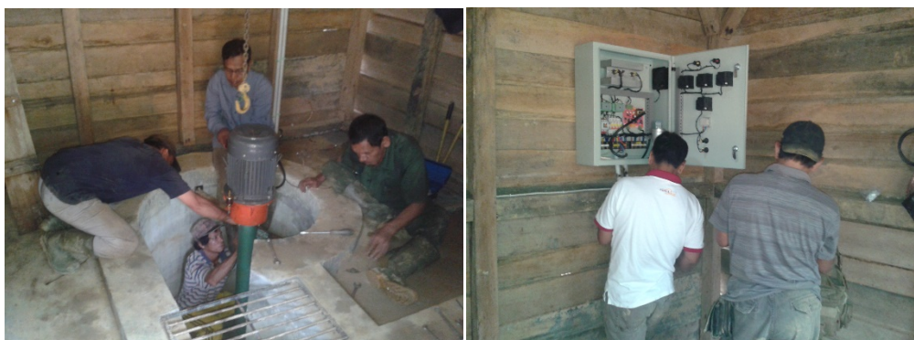
Gambar 14. Instalasi turbin dan peralatan pendukungnya
