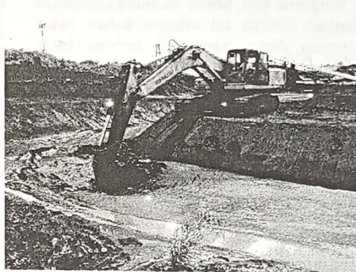
Gambar 3. Proses pengambilan sludge di lokasi PT Tanito Harum
