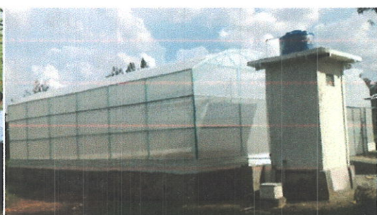
Gambar 12. Pembangunan Laboratorium Penyemaian untuk Tanaman Organik NSTP
