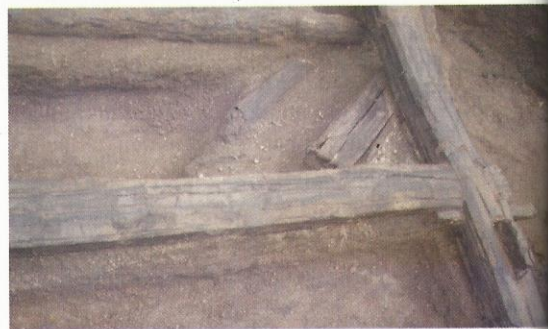
Foto no. 4 Teknik konstruksi tiang bangunan Uma Ceko (siku)
